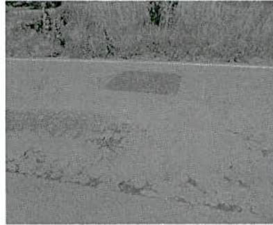
**Imagen 5.** Agrietamiento tipo piel de cocodrilo y baches parchados
