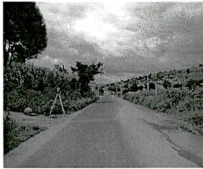
**Imagen 2.** Se observa que por no existir cunetas hay baches los que van generando erosión y desgaste
