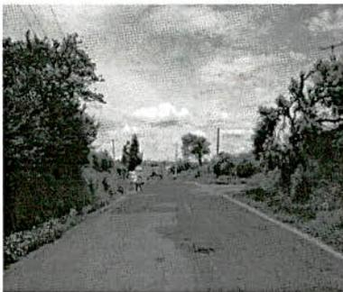
**Imagen 4.** Se observan baches, no existir cunetas, ni bordillos y la señalización es ya inexistente
