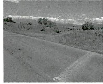
**Imagen 6.** Asentamiento por inestabilidad y desprendimiento de asfalto
